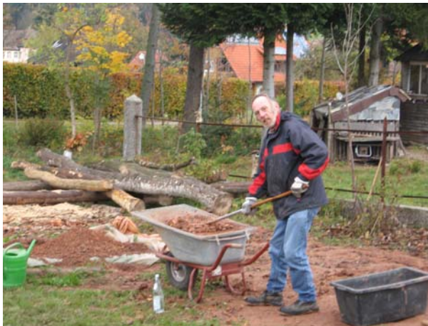
Baustelle Garten- und Gerätehaus
